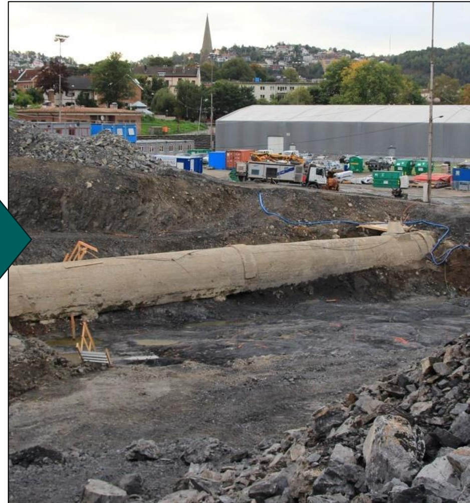
Work ongoing 2017. Photo: Kultur- og idrettsbygg Oslo KF
