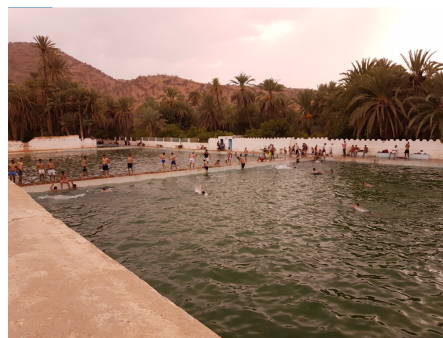
Réservoir multi-usage utilisé comme stockage pour l'irrigation et pour le loisir, Oasis de Tiout © OIEau
