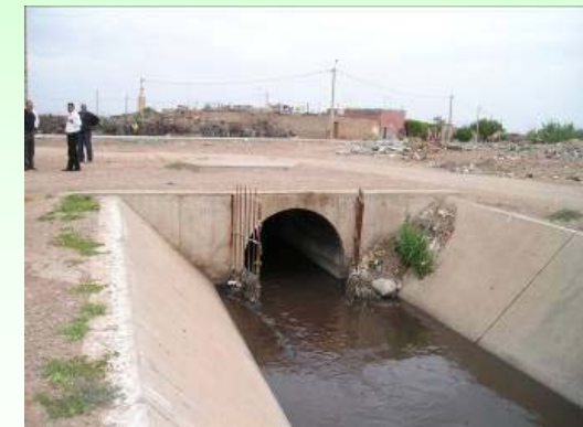
Exutoire collecteur industriel
